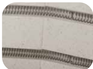
Varmelegemer, monteret beskyttet i riller
